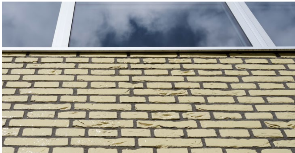
Сначала фасад был облицован обычным красным кирпичом, на который впоследствии нанесли глазурь бледно-желтого цвета. Новый кирпич сам по себе желтого цвета, а его текстура и цвет глазури точно такие же, как у оригинального кирпича.
