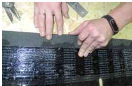
Рис. 6. Насечка для облегчения монтажа
