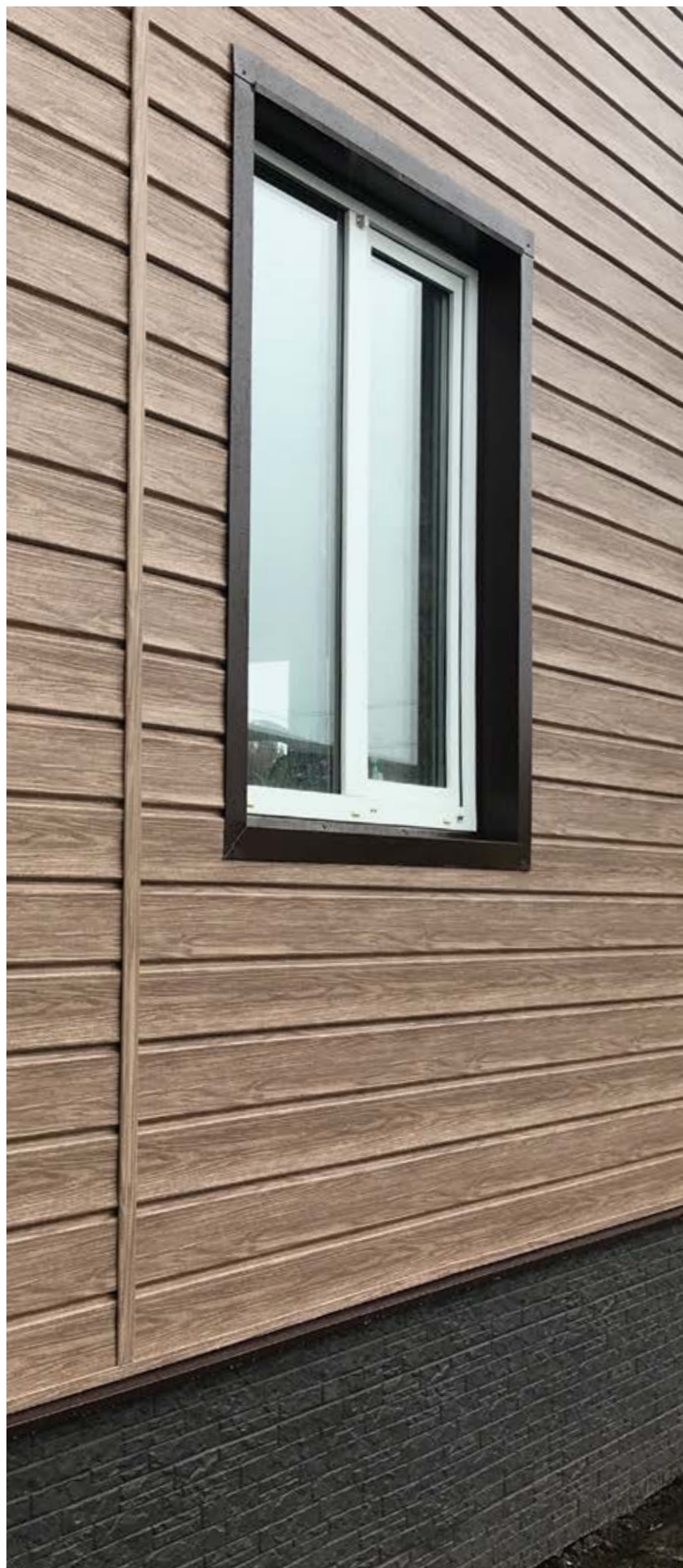
Пример монтажа сайдинга серии LUX под дерево
