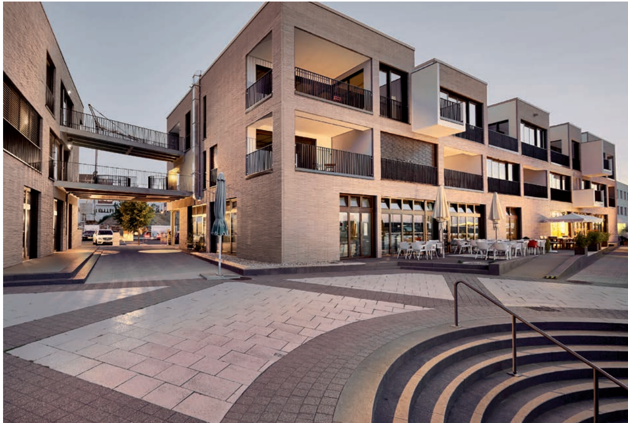
Наружные стены здания облицованы кирпичами Wienerberger Polaris длиной 510 мм.
